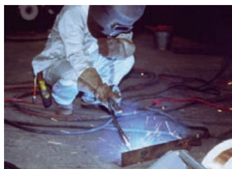
<写真2-2 アーク溶接・溶断作業>
